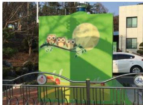
주민대피시설 환경개선 (후)
