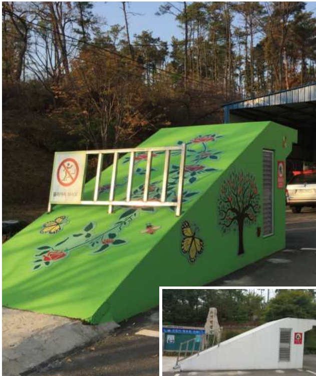
주민대피시설 환경개선 (전, 후)
